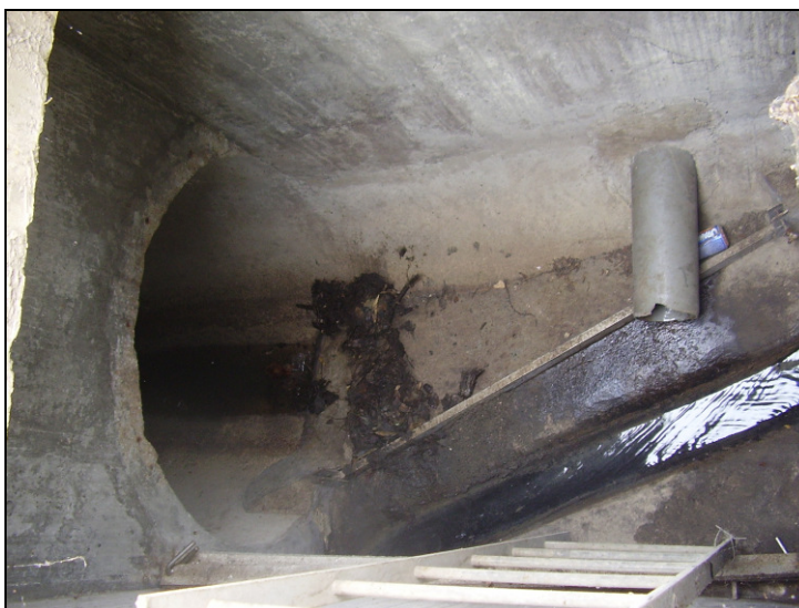
Photo 10 : DO2 rue Notre Dame vers PR Mairie –curage récent de l'ouvrage
