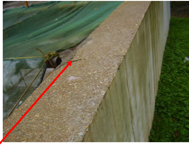
Photo 16 : Fissures sur le bassin de Biofiltration
